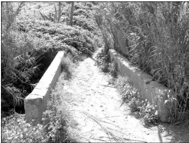
Puente de la Hedionda.
