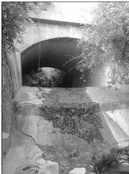
Puente de Arroyo Viña.
