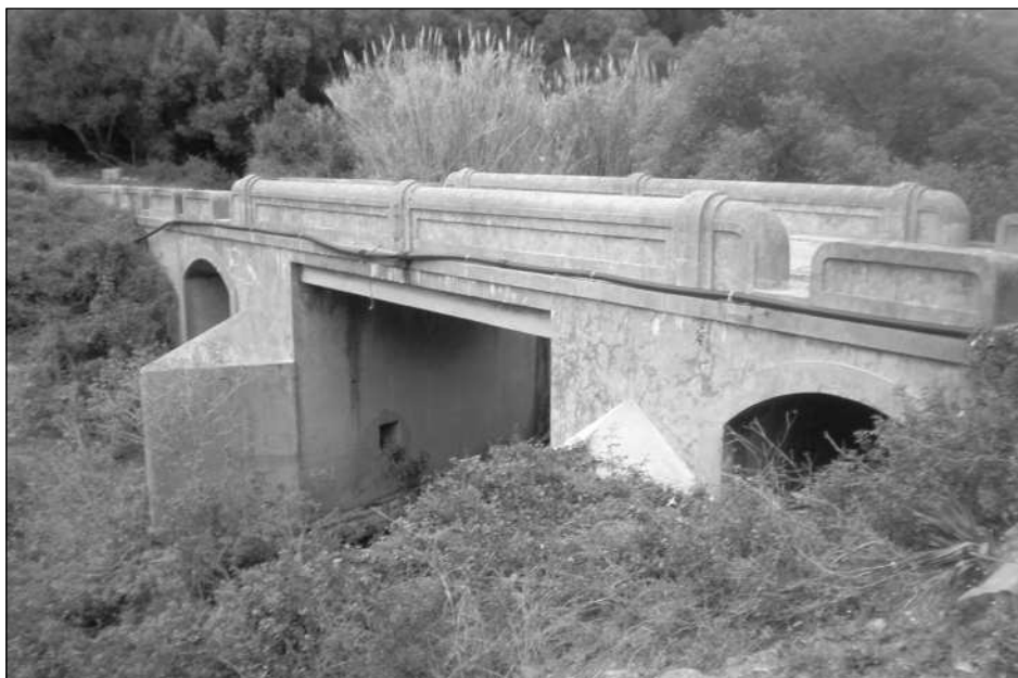
Puente de construcción militar cerca de la desembocadura del río Guadalmesí.
